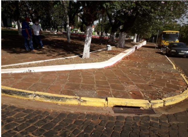
FOTO 13 - BL DA GALERIA EXISTENTE PROXIMO A AREA
