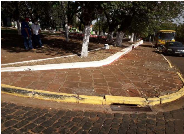
FOTO 13 - BL DA GALERIA EXISTENTE PROXIMO A AREA
