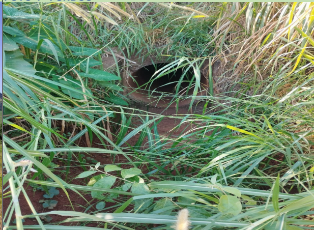
FOTO 6-SAÍDA EXISTENTE INÍCIO DA OBRA
