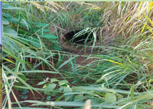
FOTO 6 - SAÍDA EXISTENTE INÍCIO DA OBRA
