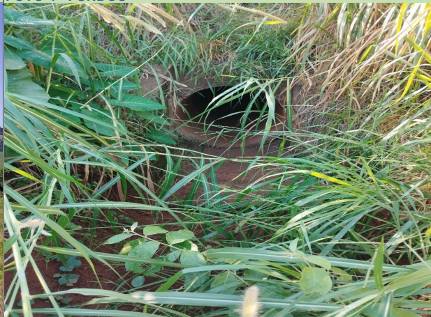
FOTO 6 - SAÍDA EXISTENTE INÍCIO DA OBRA
