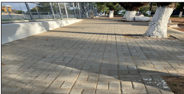
13 | PAVER LADO EXTERNO E MURETA
