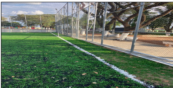
5 | FAIXA ,ALAMBRADO E PORTÃO DE ACESSO
