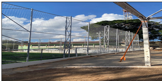
4 | ALAMBRADO ,CAMPINHO E PAVER
