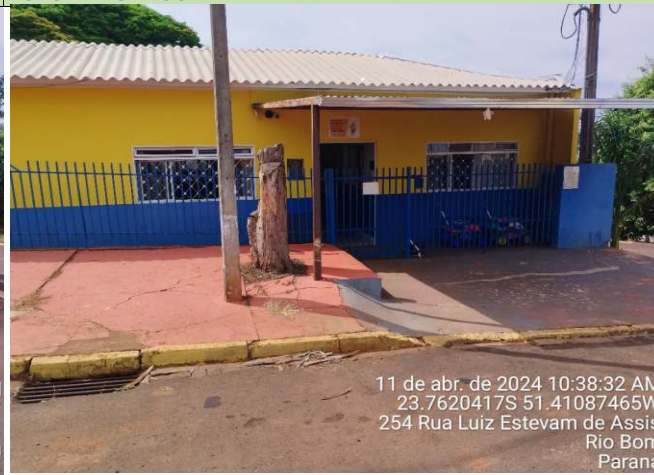
FOTO 6 - VIA DE ACESSO E ENTORNO
